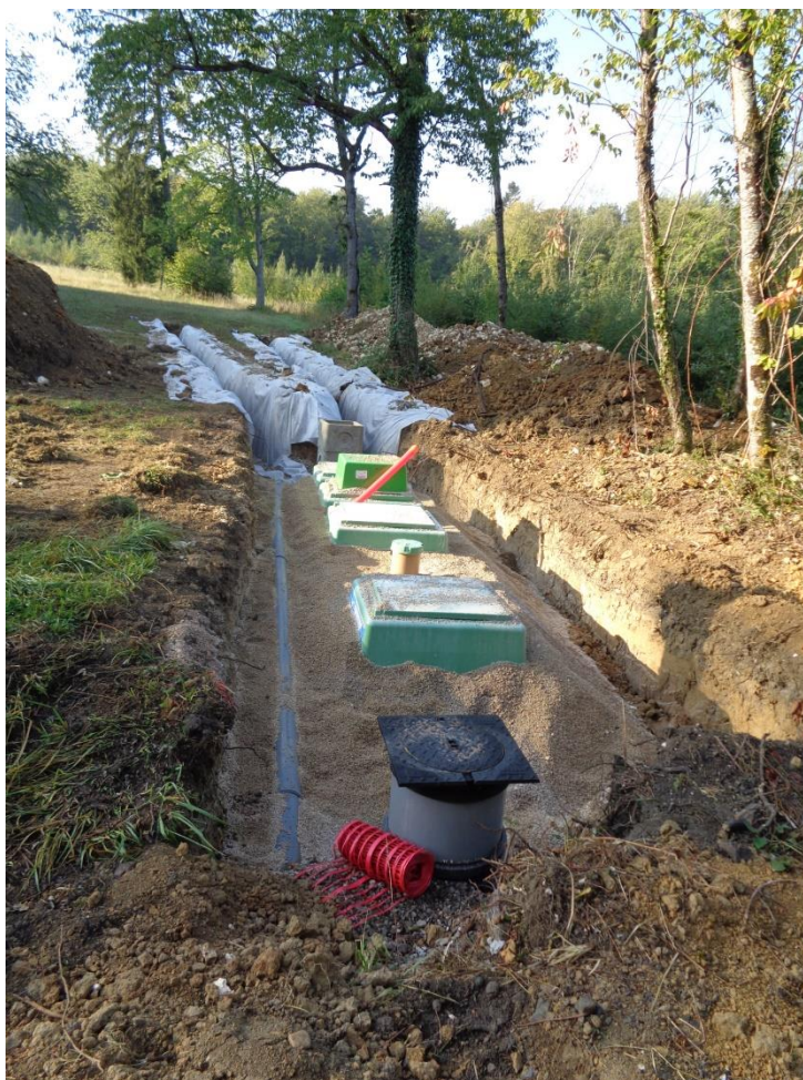
Contrôle d'une installation ANC en construction
