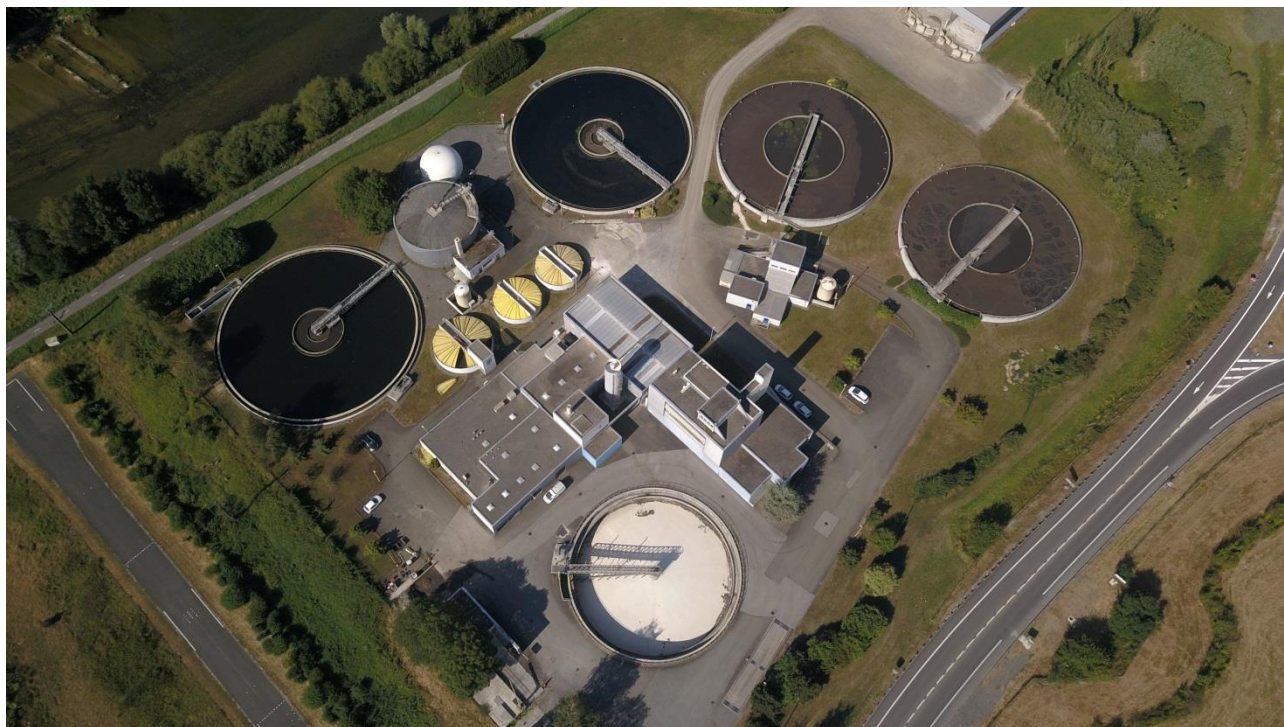
Station d'épuration d'Arbouans
