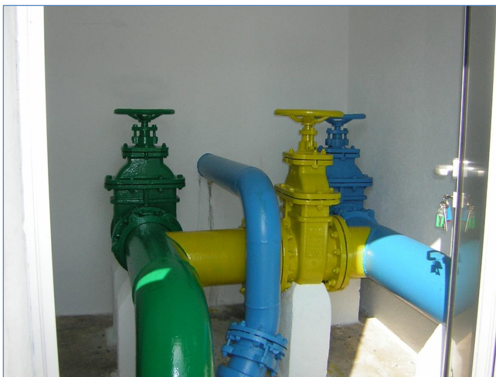
Réservoir Pont de Roide-Vermondans
